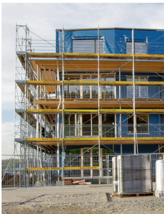
Wohnbaugenossenschaft Oberfeld, Bern
